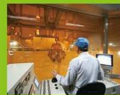
クレーン操作室(こみ攪拌作業の遠隔運転)
