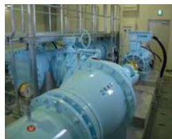
小水力発電 ・穴生発電所 (340kw)
