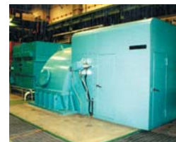
廃棄物発電 ・皇后崎工場 (36,300kw)
