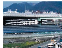
太陽光発電 ・紫川水源地 (150kw)
