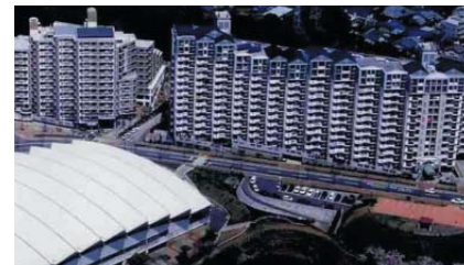
環境共生住宅「マ・テール穴生（八幡西区）」
