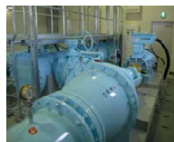
小水力発電 ・穴生発電所 (340kw)
