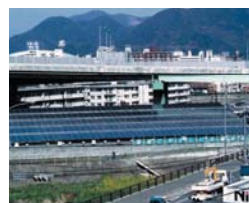
太陽光発電 ・紫川水源地 (150kw)
