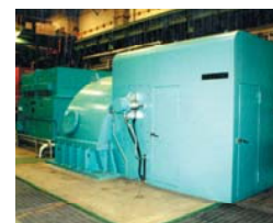
廃棄物発電 ・皇后崎工場 (36,300kw)
