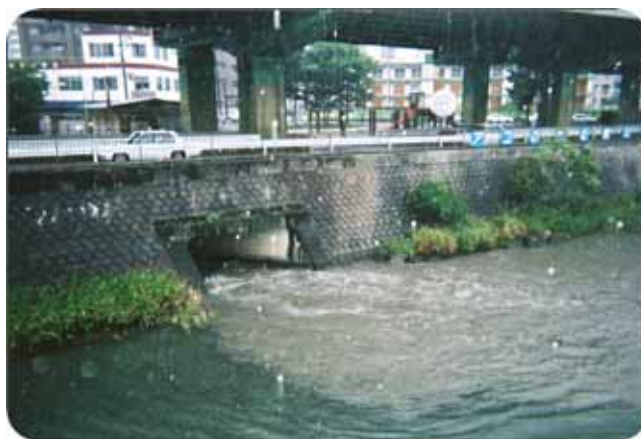
～ 未処理下水が流れ出る合流吐き口～
