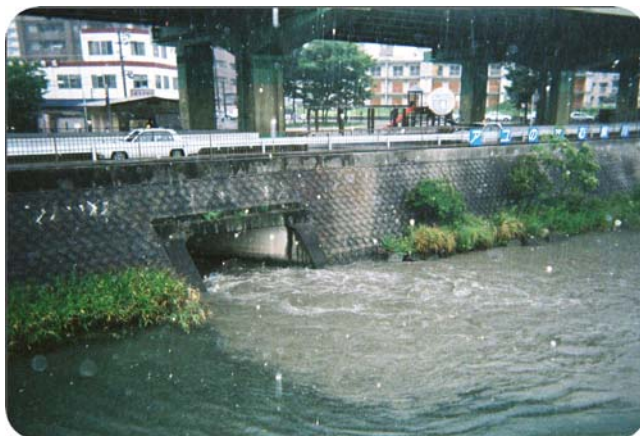
～ 未処理下水が流れ出る合流吐き口～
